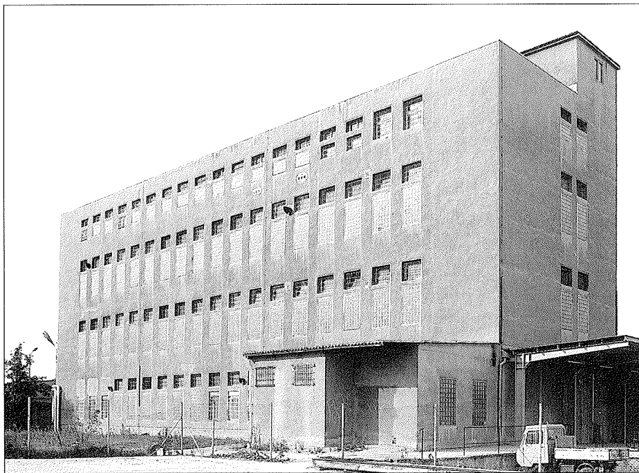
Bild 36: Werkhalle der DDR – Firma „Wittol“. In diesem Gebäude wurden u. a. Kerzen zu Beleuchtungszwecken hergestellt. Foto 1994
