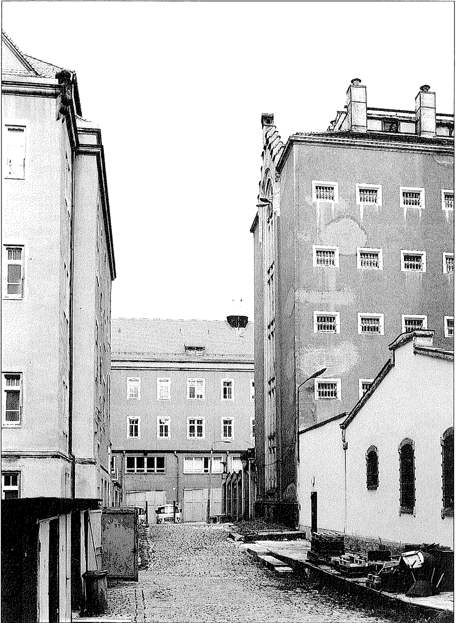
Bild 47: Durchgang zum Innenhof zwischen Gefängnis und Justizgebäude
