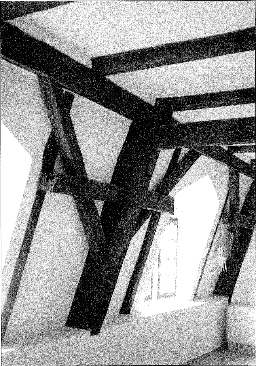
Bild 13: Instandgesetzter Raum in der Mansarde von Schloß Wildeck. Ausschnitt mit Holzbalkenkonstruktion
