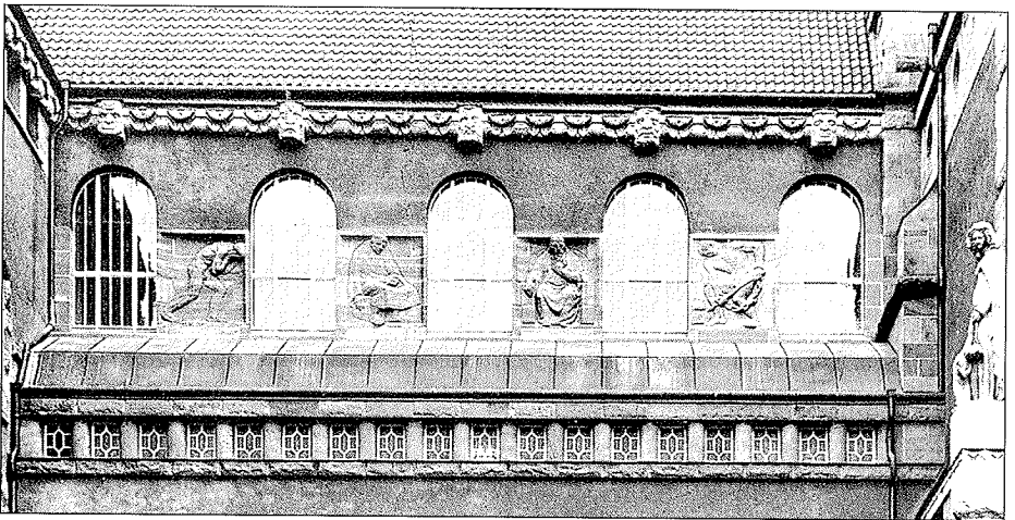
Bild 15: Landgericht, Fassade am Schwurgerichtssaal mit den Reliefs von E.Hottenroth
