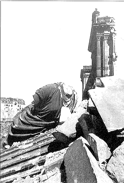
Bild 1: Teil der Ruine des Dresdner Justizpalastes in der Pillnitzer Straße 20 nach der Bombardierung vom 13./14. Februar 1945
