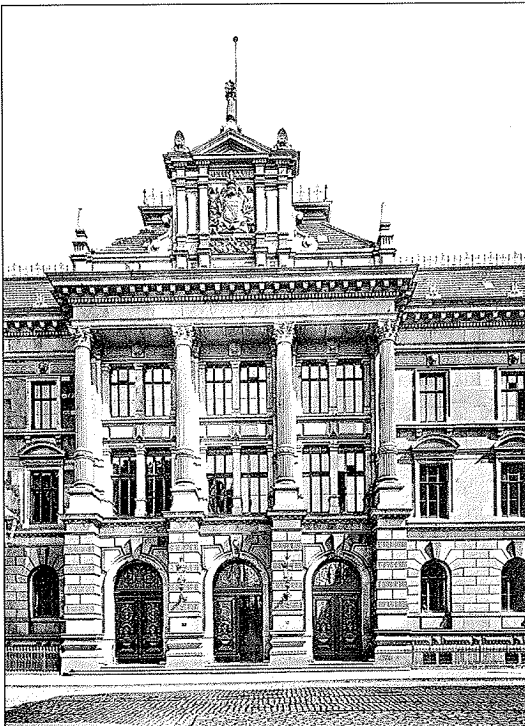
Bild 12: Mittelrisalit und Haupteingang des Dresdner Justizpalastes in der Pillnitzer Straße.
