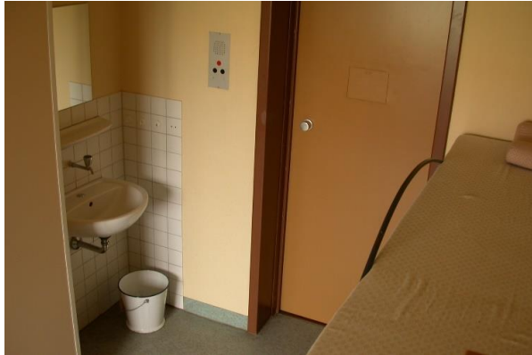
Links neben der Tür: die computergestützte Notrufanlage mit getrennten Lichttasten für Nasszelle und Haftraum
