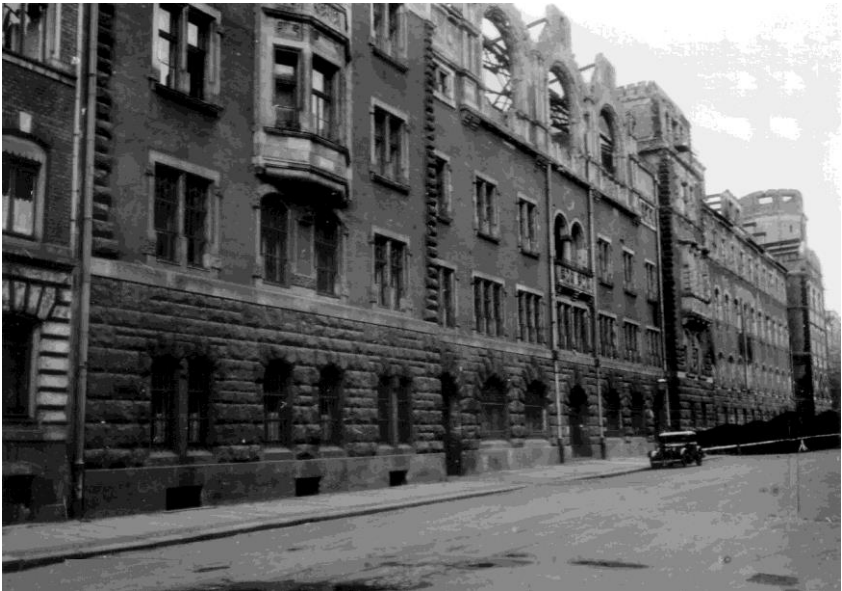
Der Haupteingang der alten Anstalt in der Alfred-Kästner-Straße (damals noch Moltke-Straße) mit sichtbaren Kriegsschäden im Dachbereich
