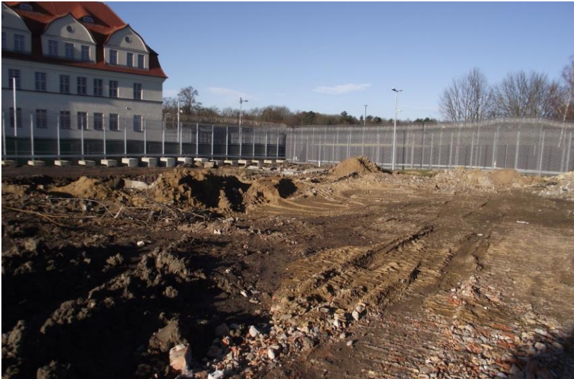
Vorbereitung des Baugrundes
