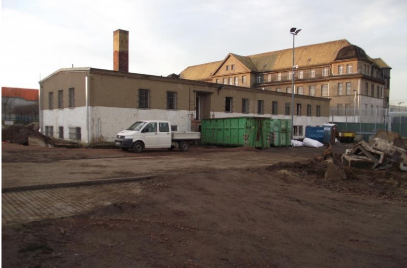
Altes Apothekengebäude vor dem Abriss auf dem Baugelände
