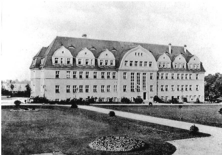
Das neben Haus 5 stehende Gebäude Nr. 4, welches noch bis zur Einweihung des neuen Krankenhauskomplexes genutzt wurde.
