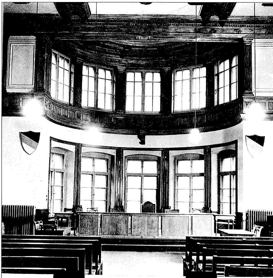
Schwurgerichtssaal im ersten Obergeschoß des 1876/78 errichteten alten Leipziger Landgerichts – Aufnahme vor 1933
