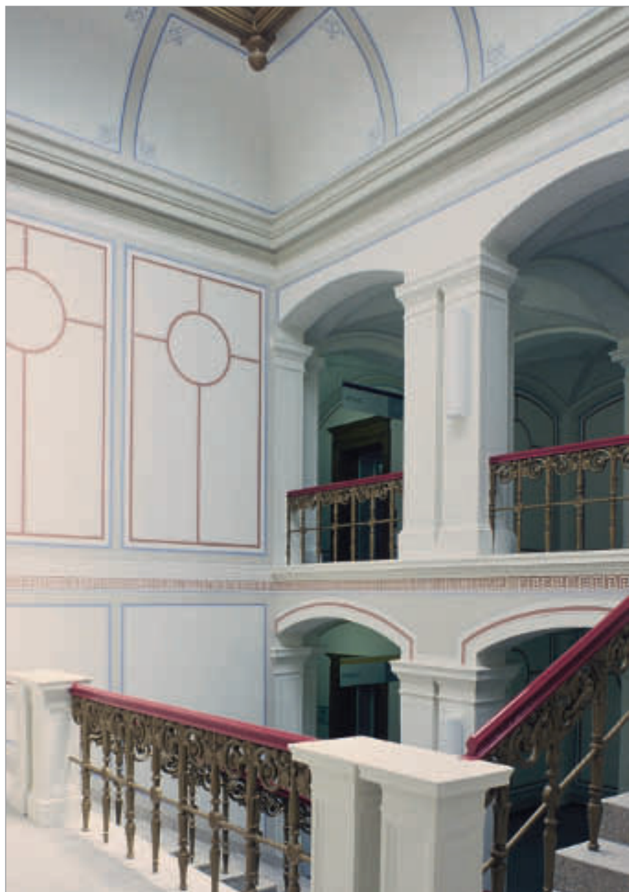
53 Treppenhaus des Altbaus nach der Restaurierung 2004.
