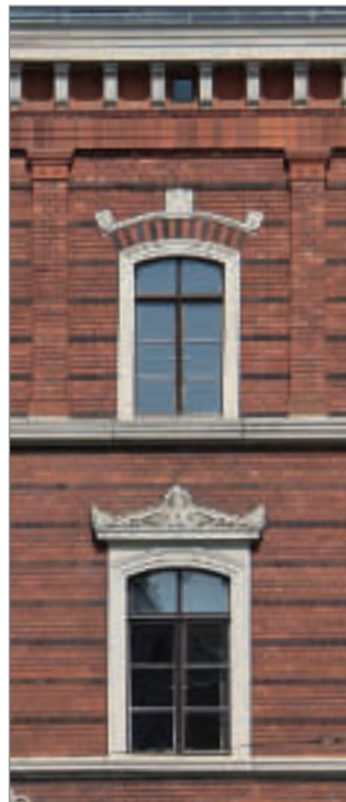
9 Fassadendetail des Görlitzer Gerichtshauses.
