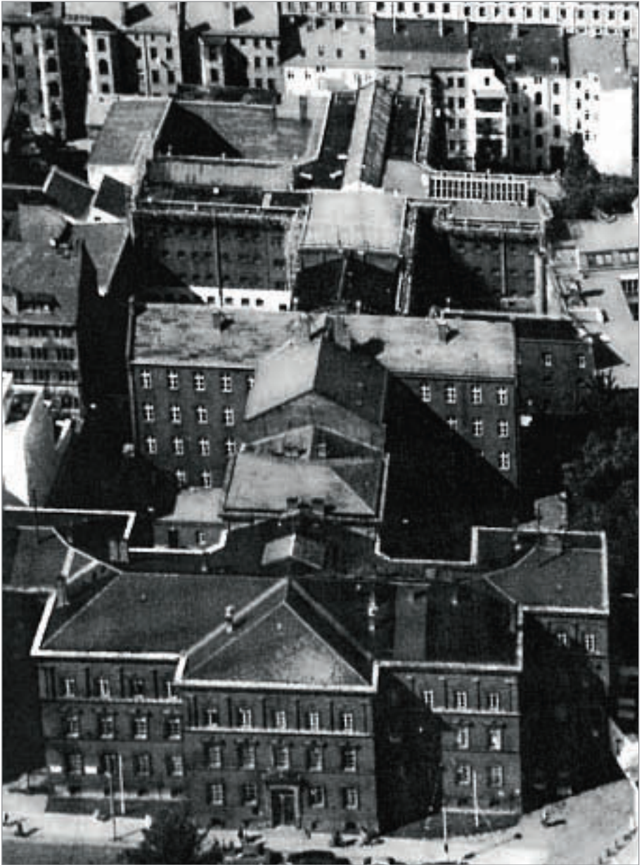
17 Gerichtsbaus und Gefängnis mit der Grundrissgestalt von 1910 bis 2001. Der T-förmige Baukörper von 1910 schloss unmittelbar an dem Schwurgerichtstrakt an. Die Gefängnishöfe sind am oberen Bildrand gut erkennbar.
