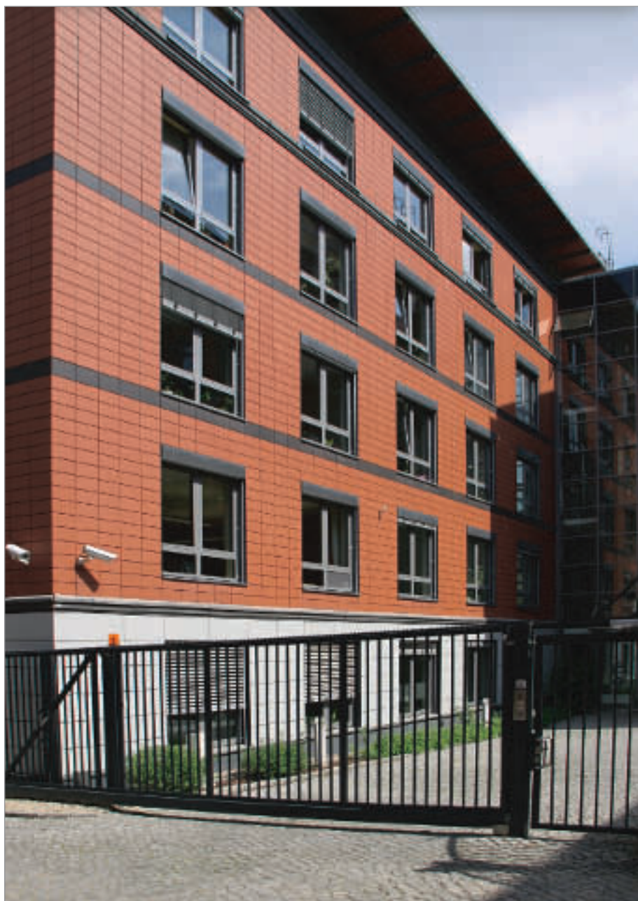
13 Das neue Gebäude hinter dem Landgericht.
