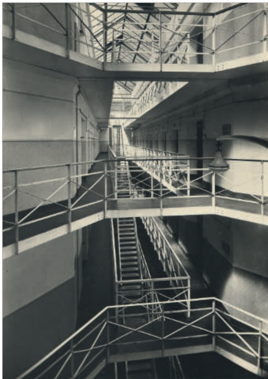
16 Gerichtsgefängnis Görlitz, Treppenanlage aus dem Jahr 1910.
