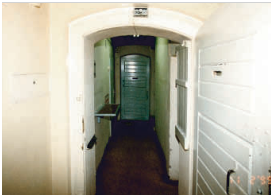
20 Der ursprüngliche Gefängnisbereich, erbaut 1863 bis 1865. Zustand vor dem Abriss im Jahre 1999.
