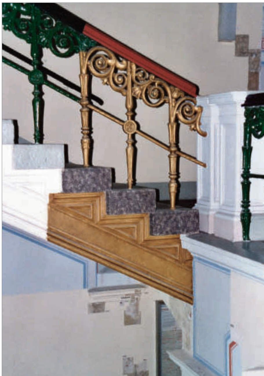
54 Befundachse im Treppenhaus.
